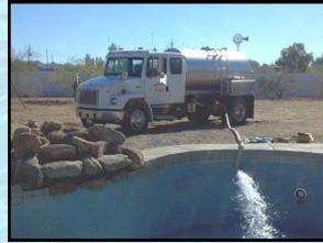
**Mise en route de la piscine :** notre finition en polymère thermique est une surface extrêmement durable qui ne nécessite aucun traitement chimique pour aider dans le processus de durcissement. Cela donne la possibilité de se baigner dès que la piscine est remplie.
